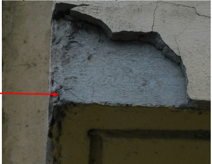
Kondygnacje niższe I etap zmieszczenia -zarysowania i odpadanie tynku
