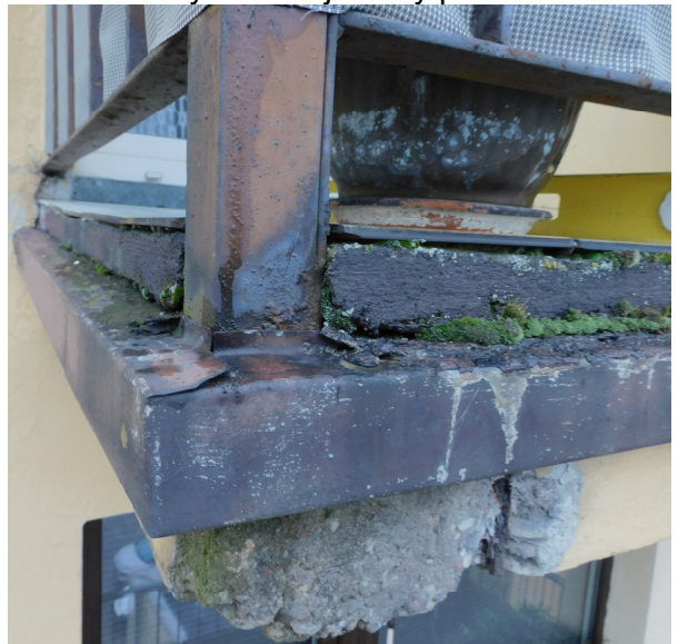
Kolejne przykłady zamieszczenia płyty balkonów pod pasem okapowym
