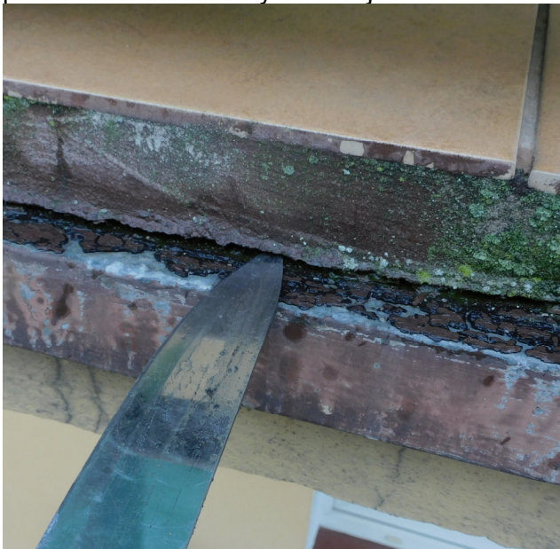
Widoczny brak scalenia jastrychu z podłożem
