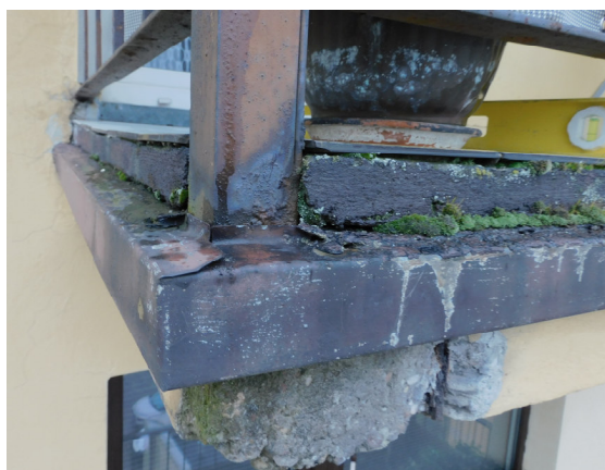
Charakterystyczne miejsca przecieków i ich skutki - balkony elewacji zachodniej
