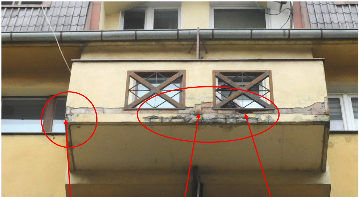
Najbardziej zaawansowana destrukcja balkon podwójny najwyższej kondygnacji
