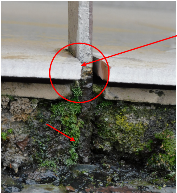
Skutki przecieków wody przez nieszczelną obróbkę blacharską w miejscu zamocowania płaskownika balustrady stalowej
