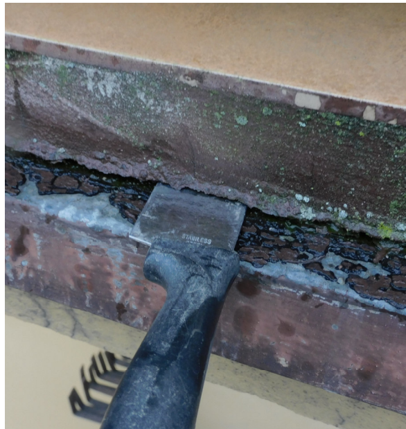
Skutki przecieków wody przez nieszczelną obróbkę blacharską w miejscu zamocowania płaskownika balustrady stalowej
