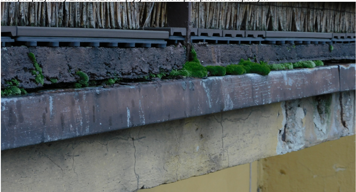
Kolejne przykłady zamieszczenia płyty balkonów pod pasem okapowym
