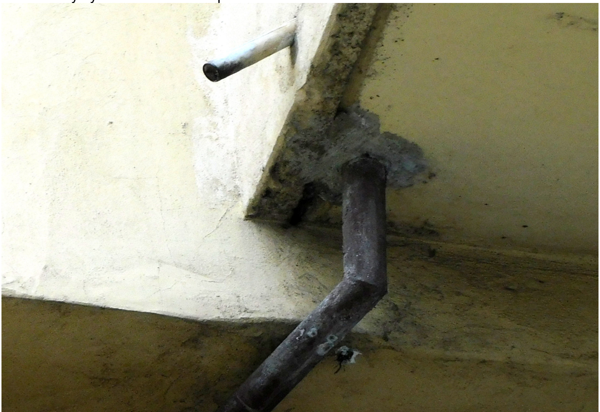
Nieszczelny system odwadniania posadzki balkonów
