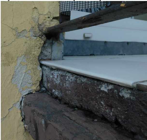
Kolejne przykłady zamieszczenia płyty balkonów pod pasem okapowym
