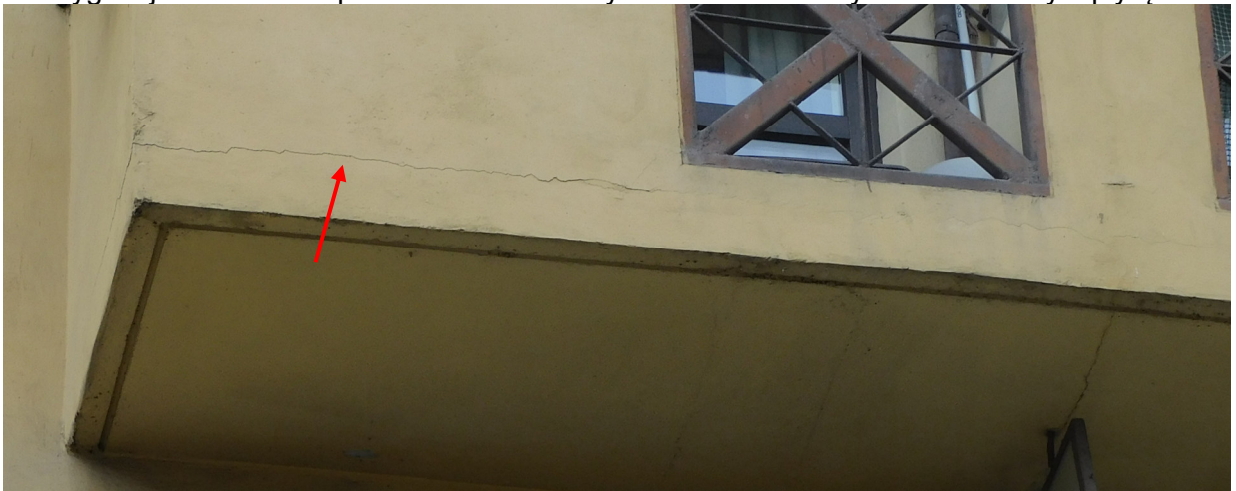
Nieszczelny system odwadniania posadzki balkonów
