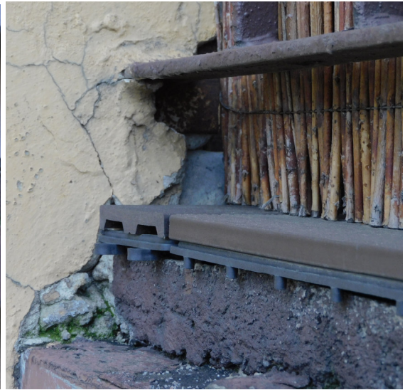
Wykruszenia i destrukcja w miejscu zamocowania balustrady stalowej -dolny płaskownik
