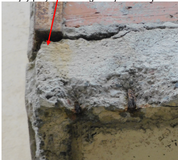
Kondygnacje niższe I etap zmieszczenia -zarysowania i odpadanie tynku
