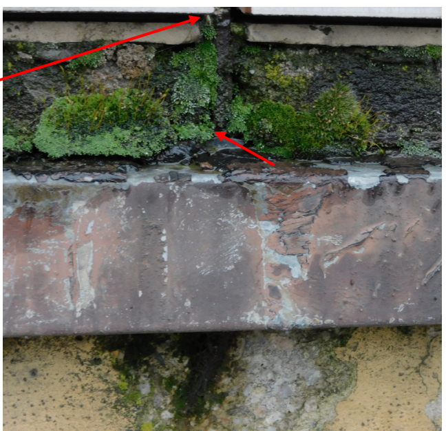
Skutki przecieków wody przez nieszczelną obróbkę blacharską w miejscu zamocowania płaskownika balustrady stalowej
