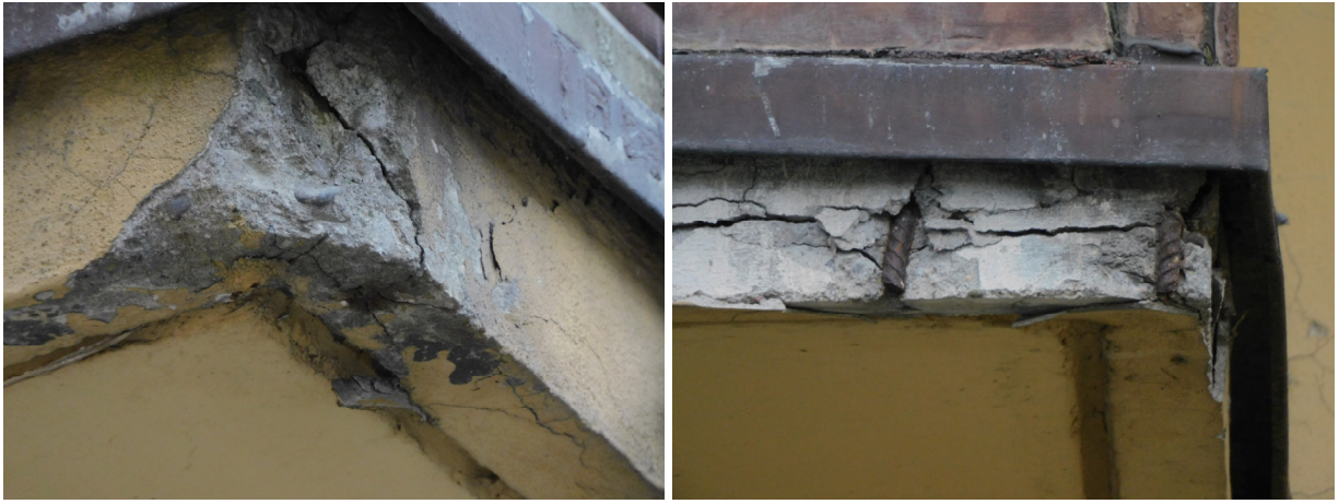
Kolejne przykłady zamocowania płyty balkonów pod pasem okapowym
