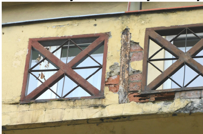
Przenikanie wody na linii balustrady murowanej oraz ze ścianą osłonową i jej skutki
