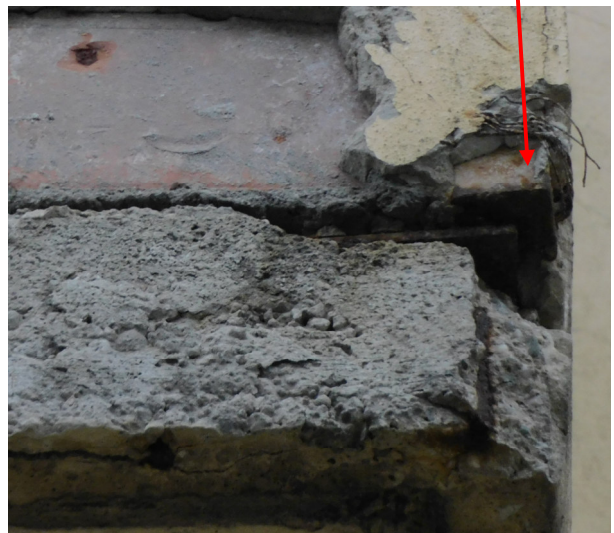
Kondygnacje niższe I etap zmieszczenia -zarysowania i odpadanie tynku
