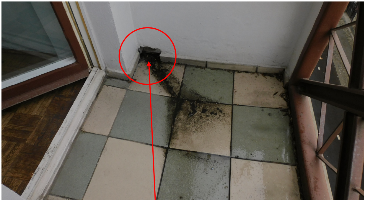
Wadliwe wykonanie odwodnienia posadzki balkonów -brak szczelnych wpustów podłogowych
