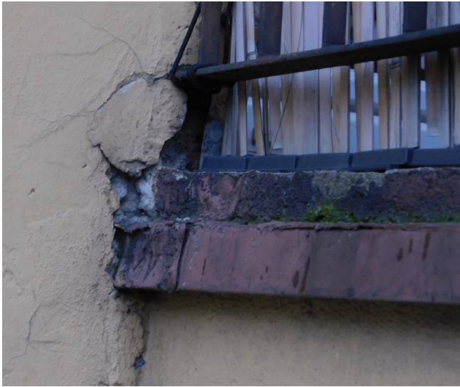
Wykruszenia i destrukcja w miejscu zamocowania balustrady stalowej -dolny płaskownik
