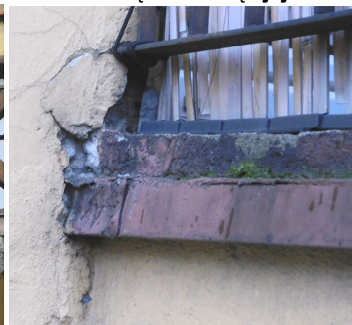
Przenikanie wody na linii balustrady murowanej oraz ze ścianą osłonową i jej skutki
