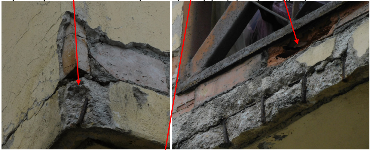
Najbardziej zaawansowana destrukcja balkon podwójny najwyższej kondygnacji
