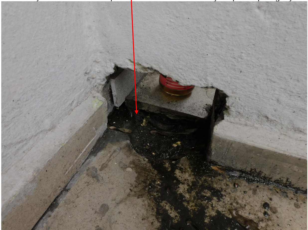
Wadliwe wykonanie odwodnienia posadzki balkonów -brak szczelnych wpustów podłogowych
