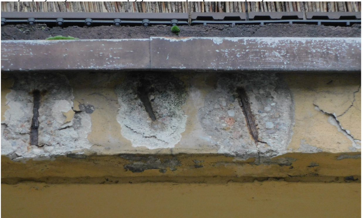
Kolejne przykłady zamocowania płyty balkonów pod pasem okapowym
