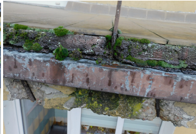
Charakterystyczne miejsca przecieków i ich skutki - balkony elewacji zachodniej
